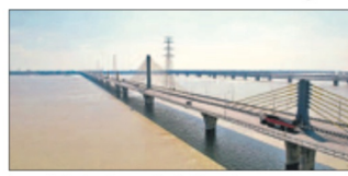
बेगूसराय के बीच गंगा नदी पर बना आँटा-सिमरिया छह लेन पुल।
